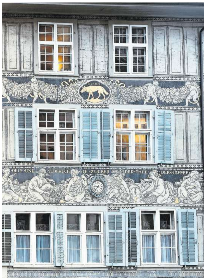
Fassaden-Sgraffito am Haus «zum Wolf», Spalenberg 22.
